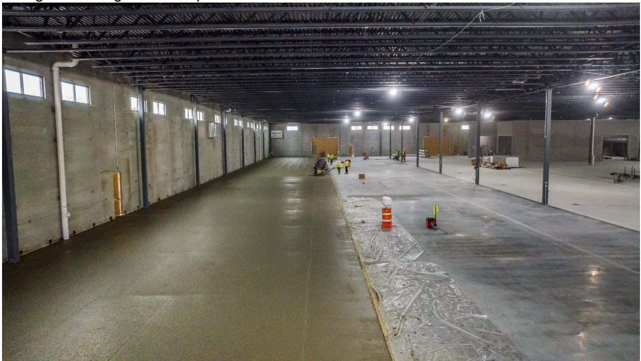
Garage - final large concrete pour
