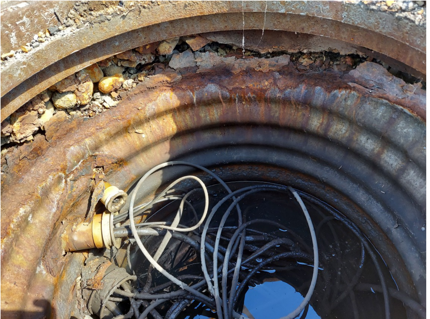
NE Island Manhole
