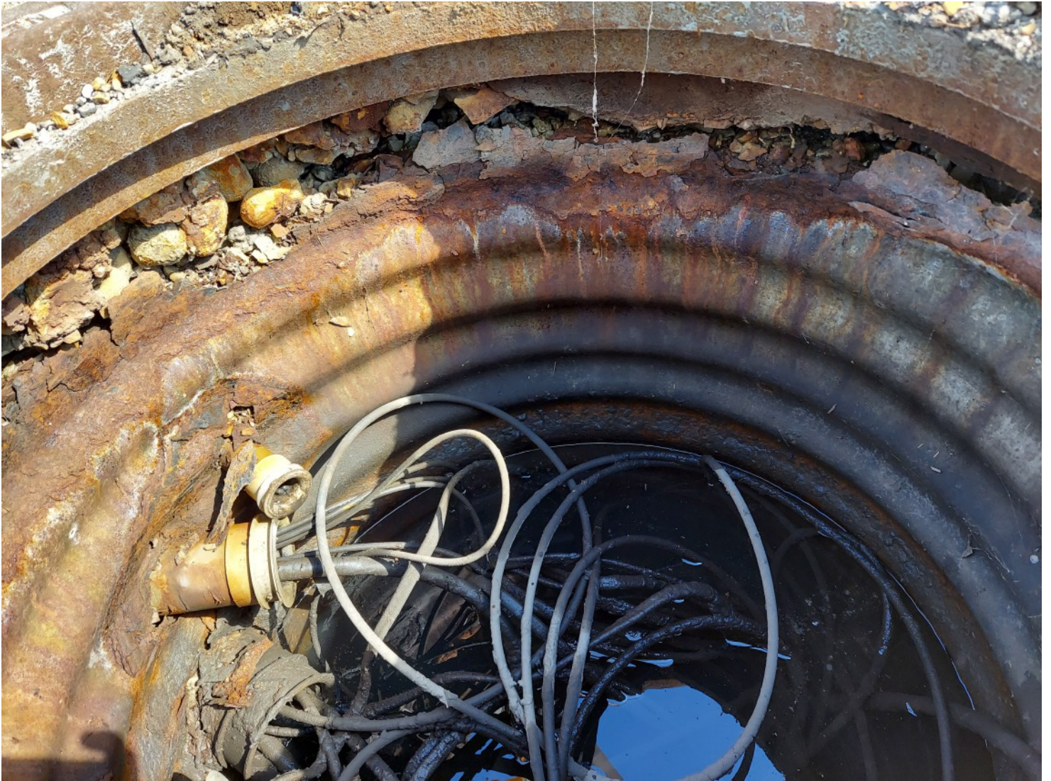
NE Island Manhole
