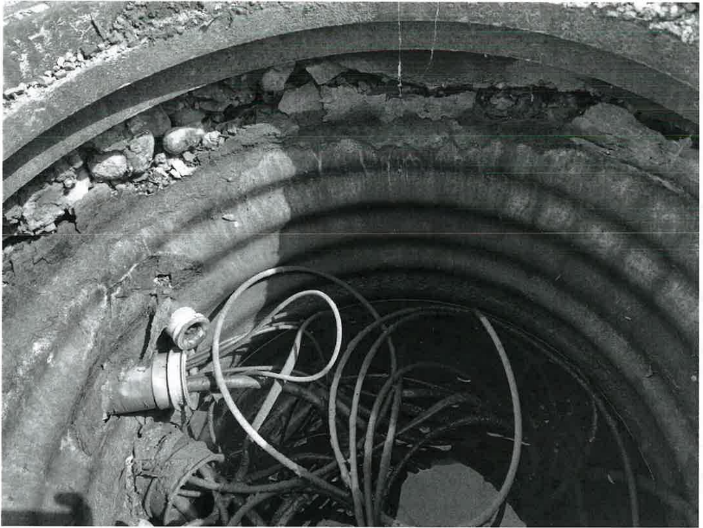
NE Island Manhole
