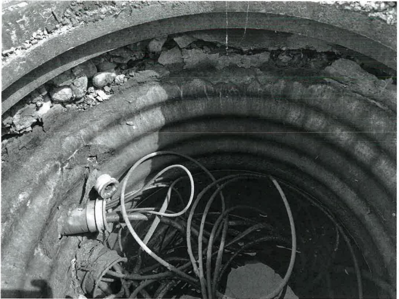
NE Island Manhole
